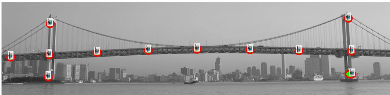
橋梁モニタリングシステム     📡: センサ端末
